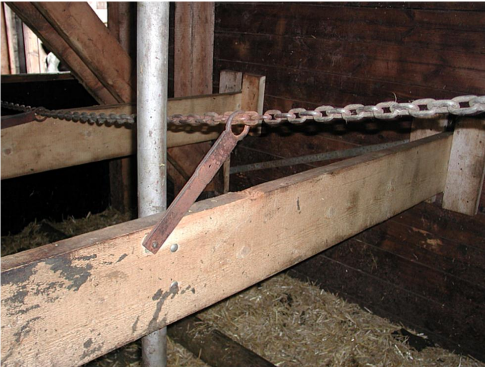
Bild 1: Nackenkette mit Klappmechanismus für Tiere unterschiedlicher Größe.
