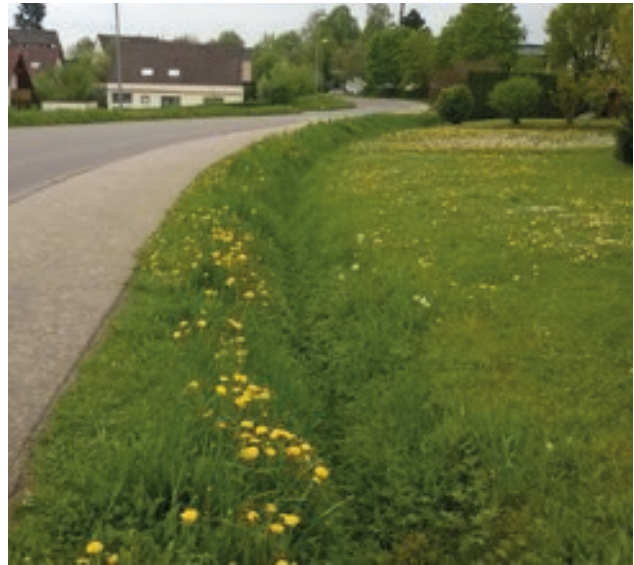
Abb. 4.8: Gleiches gilt für Entwässerungsgräben.
